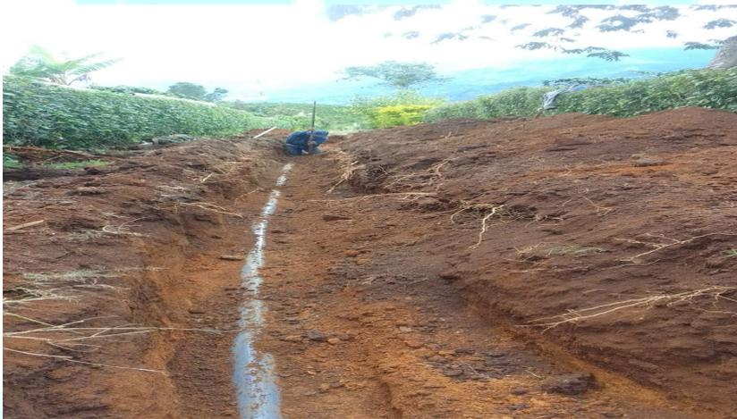
*Ilustración 29. cambio de tubería agrietada.*
