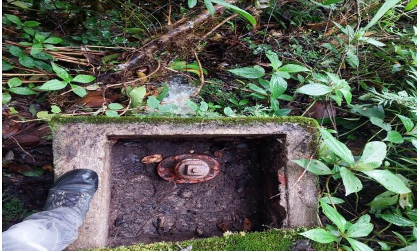
*Ilustración 28. reparación de fuga en la tubería secundaria.*
