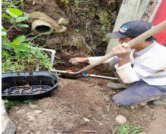
*Ilustración 20. Instalación de micromedidores.*
